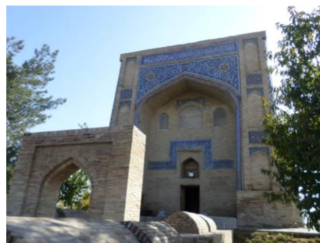
Западный и главный фасад мавзолея. Фото: М.Бекназаровой, 2022 г.
